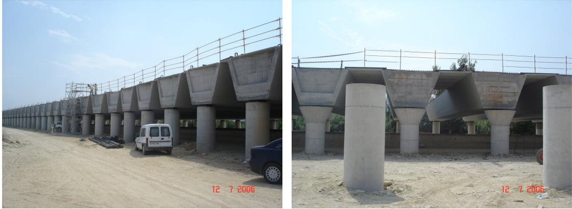
Figura 21: Viaducto «Pérgola» con elementos transversales, en la línea Madrid–Valencia. Cortesía de ALVISA.
