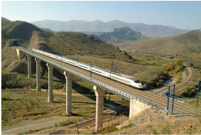
Figura 1: Vista general del viaducto de Villanueva del Jalón.
